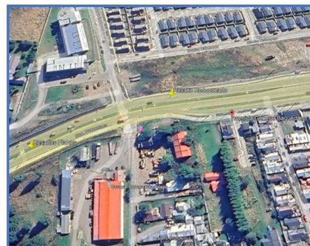
Sector PDI - Puente La Cruz
