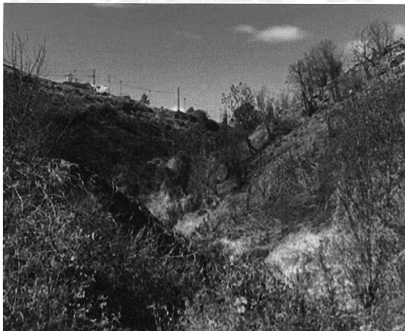
FIGURA 1: Vista actual Zona A, 12/01/2022
